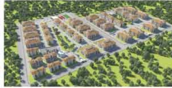
AŞİYÂN KONAKLARI - DÜZCE ( 440 DAİRE )
